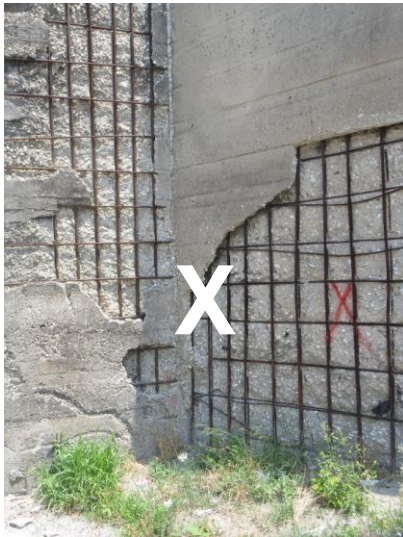
Corrosion des aciers
