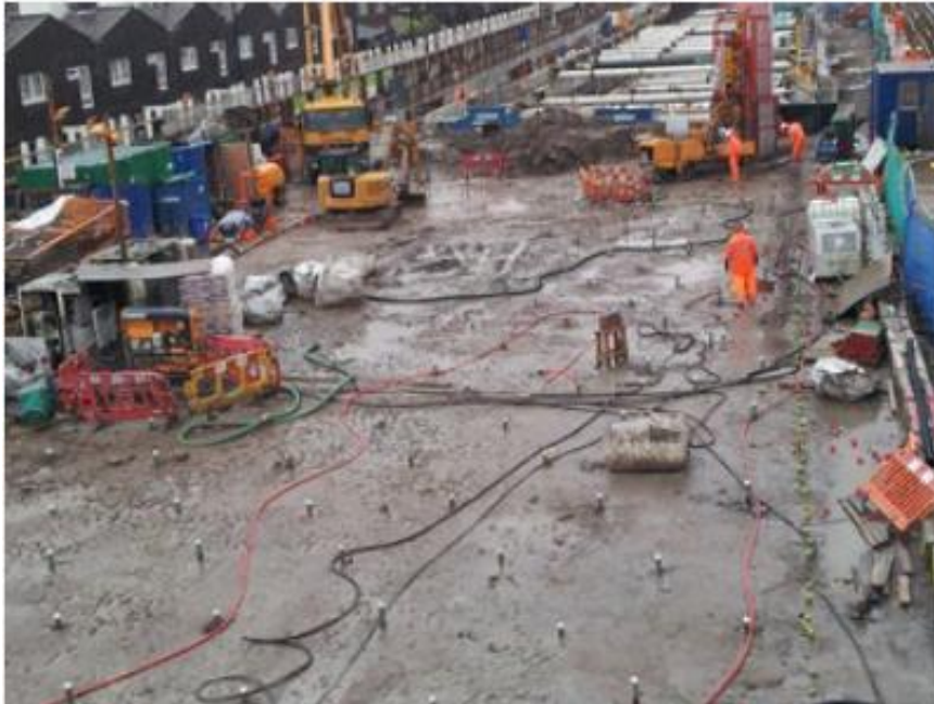
Londres, Angleterre, Injection par tube DURVINIL® S 40/50
