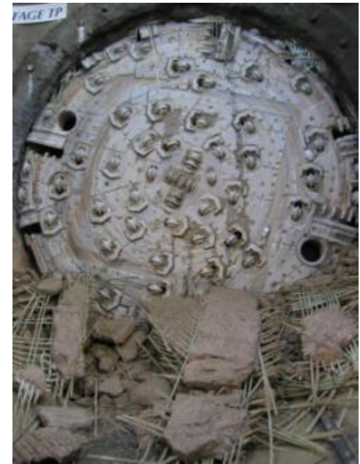
Percement du tunnelier
