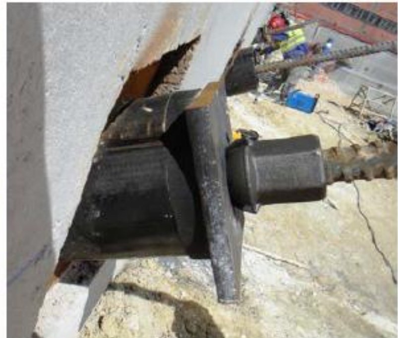
Tête de blocage métallique pour la précontrainte
