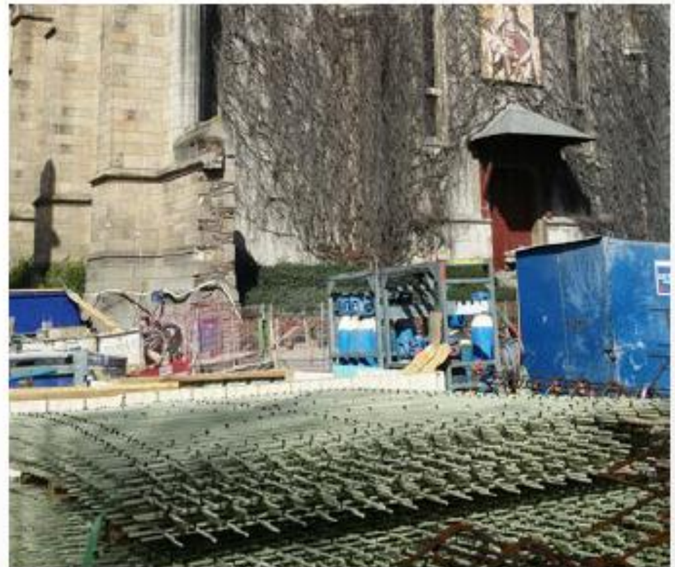
Treillis DURGLASS® avant l'installation
