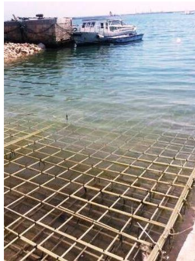
Armatures en fibre de verre Glaspree® non corrosives..
