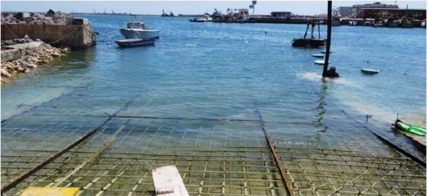
Armature GLASSPREE® pour une dalle portuaire
