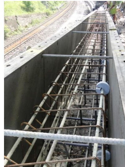
Armatures en fibre de verre Glaspree® non corrosives..
