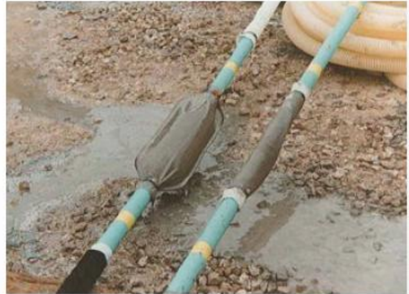
Tubes DURVINIL® S avec sacs obturateurs
