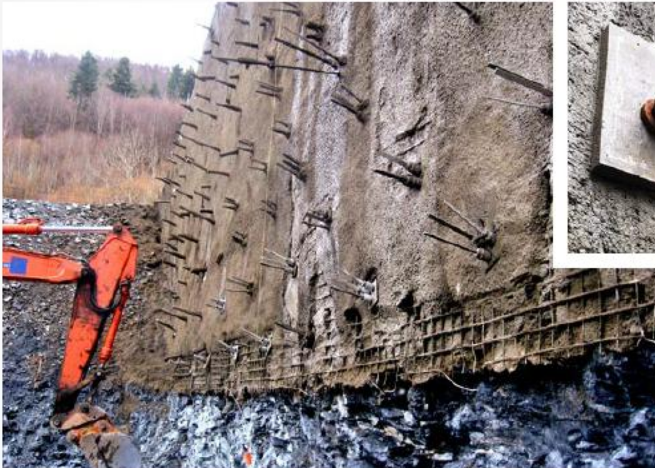
Tête de blocage pour clou tri-lame
