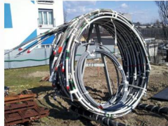
Tube DURVINIL® A 27/34 enroulé dans un tirant câble
